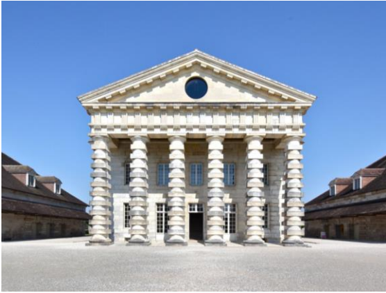
Salina Real de Arc-et-Senans en Chaux (Francia). Descomponiendo las columnas y pilastras clásicas recompone un nuevo orden alternado tambores y prismas.
